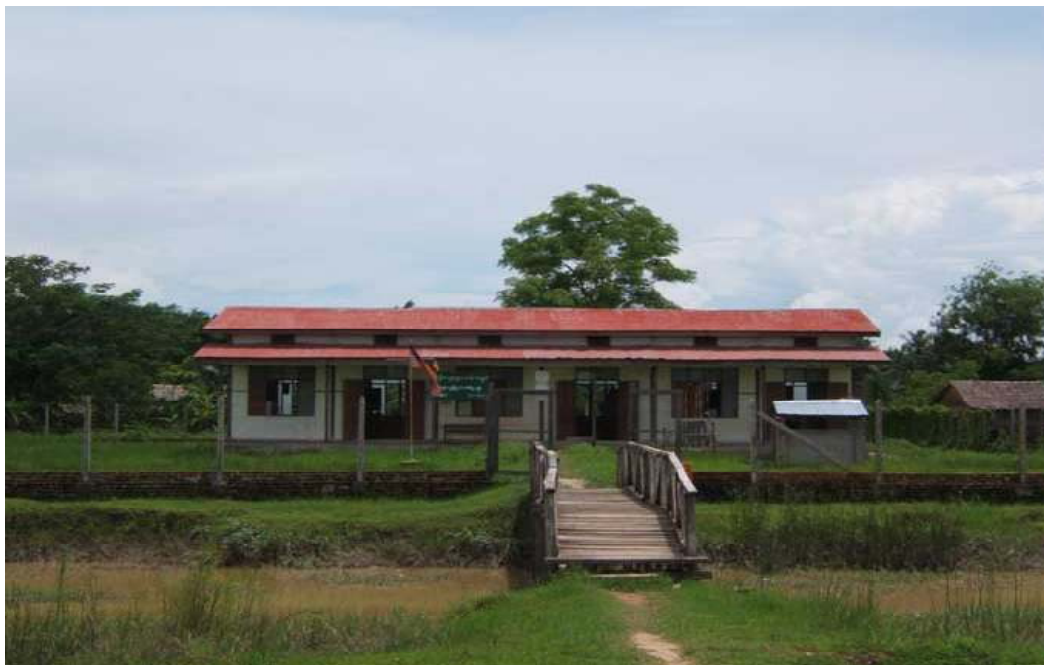
↑引き渡し後1周年を経たトンテ小学校、橋が新設されてます。
